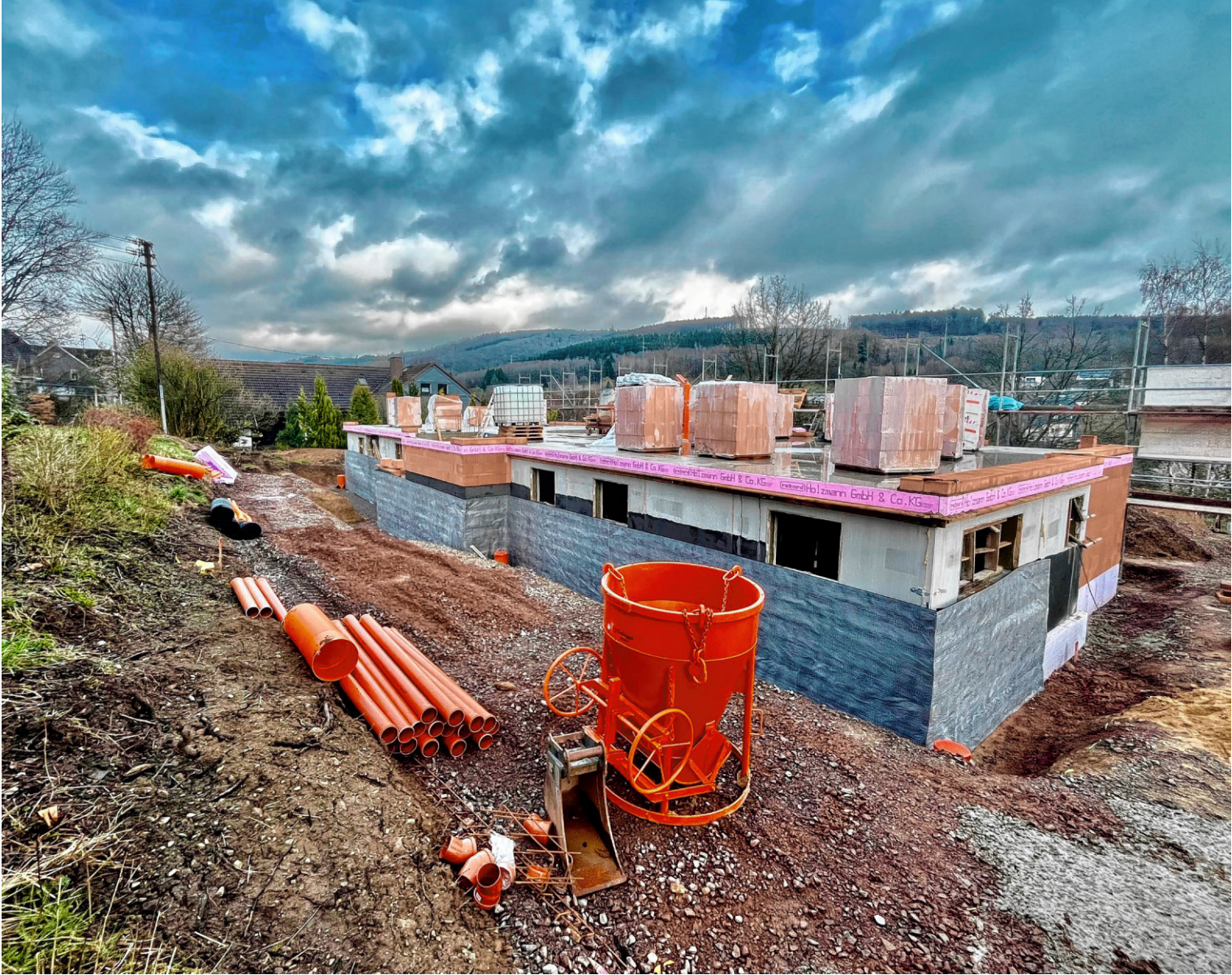
Das erste Mehrfamilienhaus in Welschen Ennest ist bereits im Bau. Acht neue Wohnungen entstehen hier.
