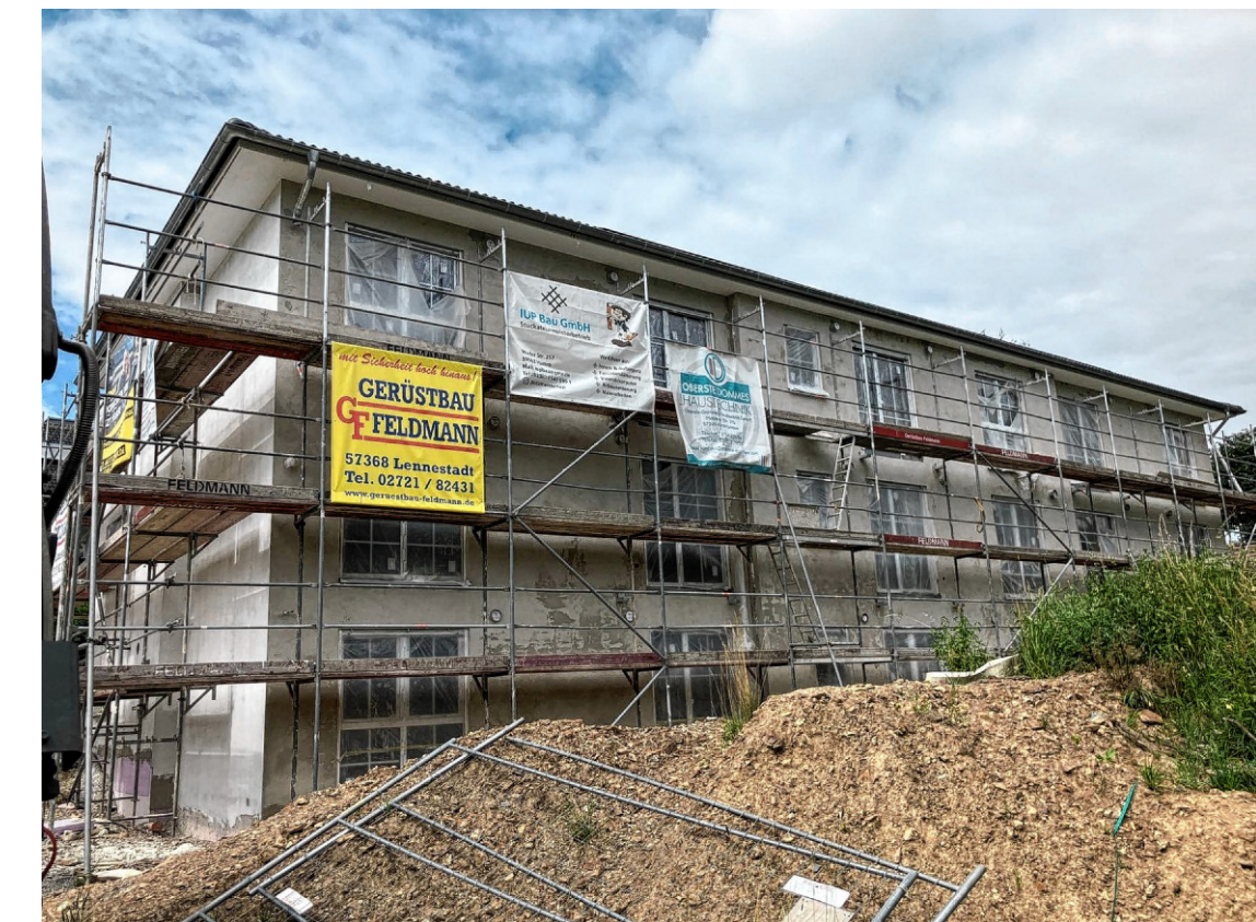
Das erste Mehrfamilienhaus der Hegener Welschen Ennest eG&B am Johann-Heinrich-Limper-Weg soll im Oktober bezugsfertig sein. Für das zweite Haus liegt die Baugenehmigung vor, aber es fehlt die Fördermittelzusage.
